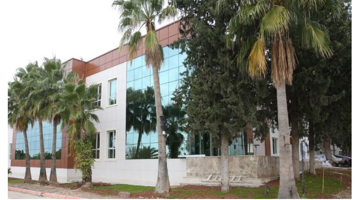
YADYO'nun karşısında PTT önünde Dış İlişkiler Binası Zemin katta Dış İlişkiler Birimi
